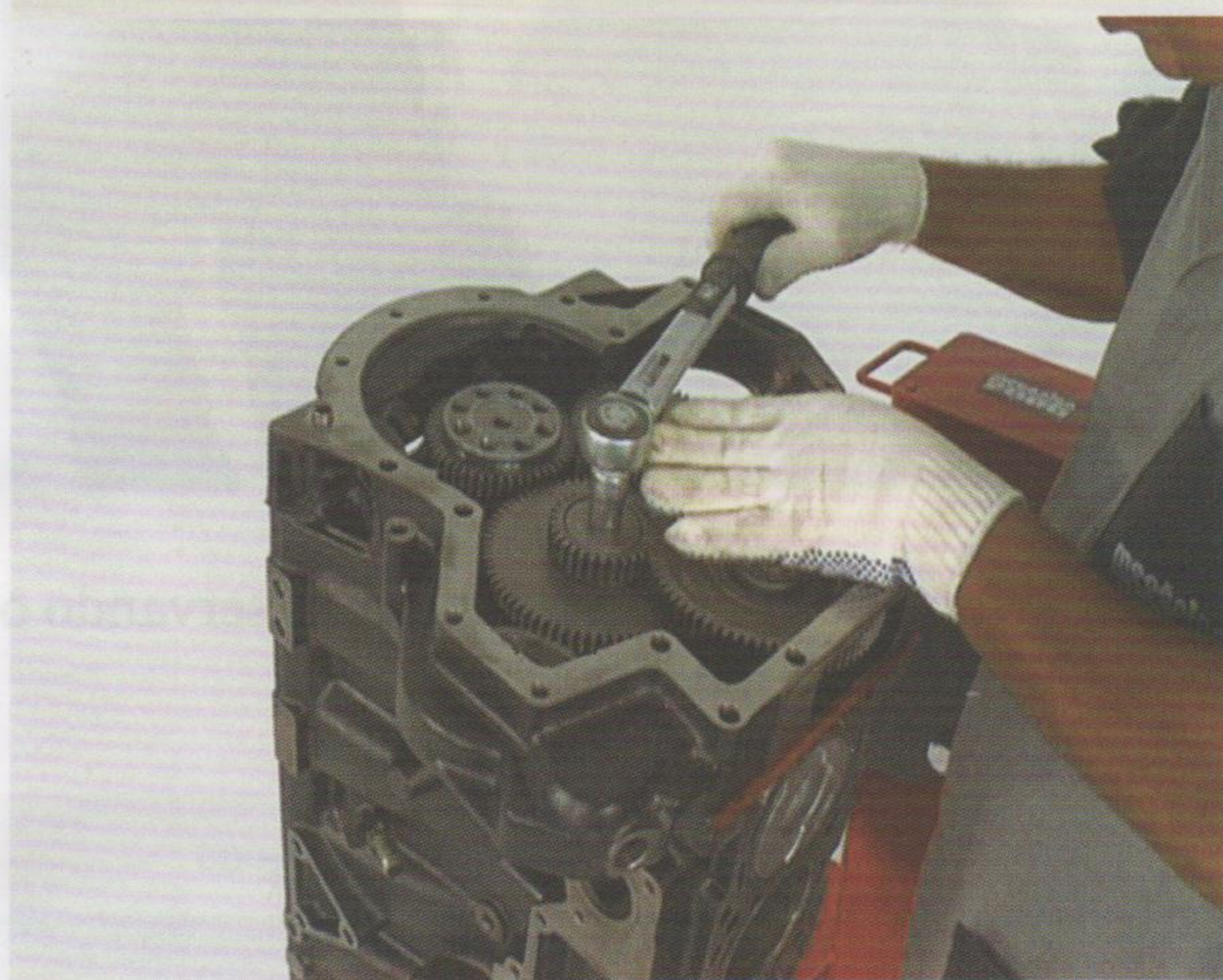
Fig.5 - Aperto dos parafusos das engrenagens
