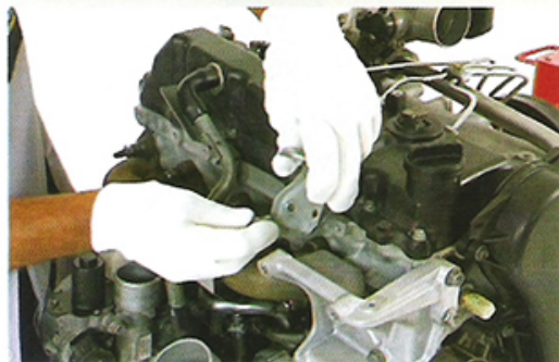
Fig.5 - Instalação dos suportes do intercooler
