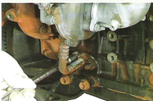
Fig.12 - Remoção da tubulação de retorno do óleo
