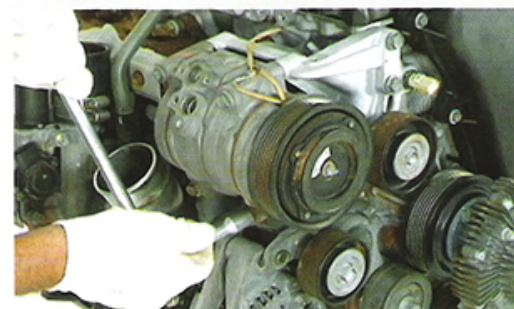
Fig.6 - Remoção dos parafusos do compressor do ar-condicionado
